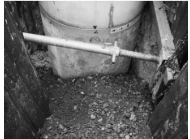
写真-2 基礎材一体化施工後
