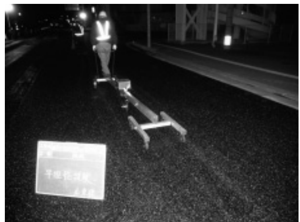
写真-3 平坦性試験状況
