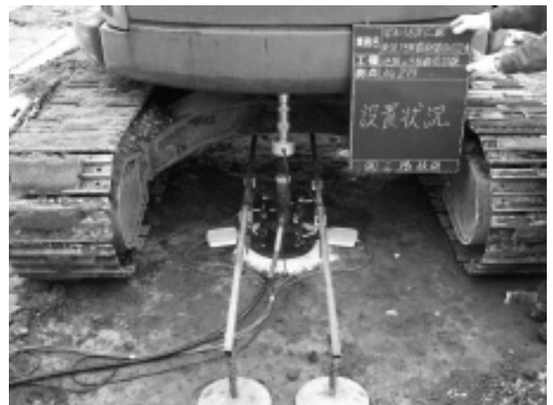
写真-1 平板載荷試験設置状況
