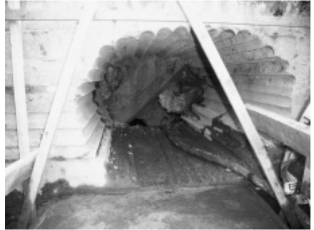
写真-4 抜き取り完了
