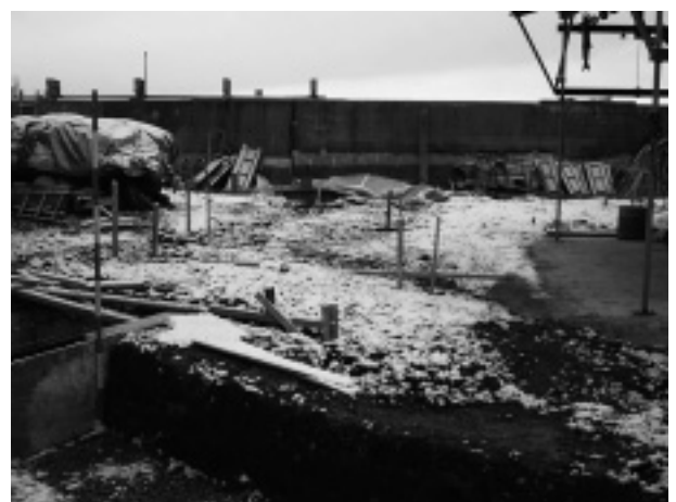
写真-2 既設護岸部
