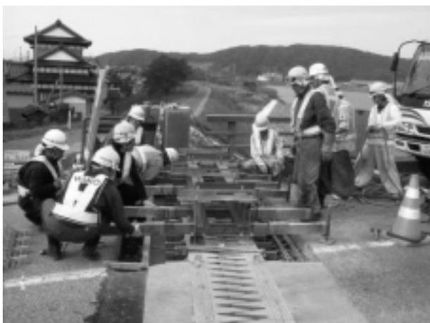
写真-2 鋼製伸縮継手仮固定状況
