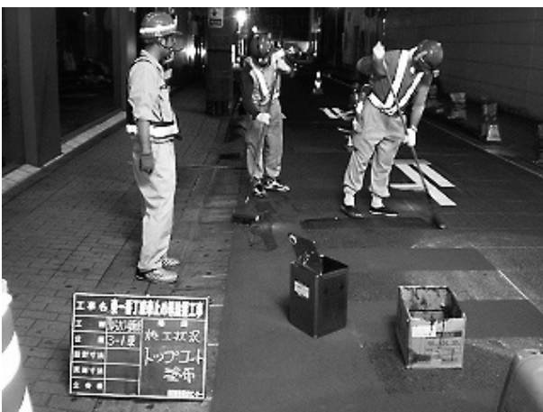
写真-3 トップコート塗布状況
