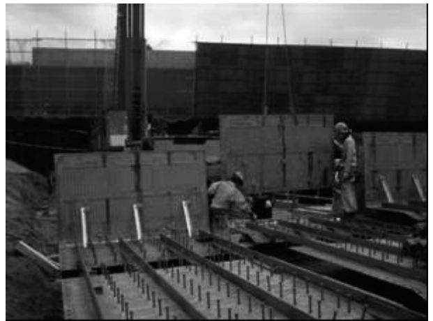
写真-2 合成床版と側面板(PCF)地組
