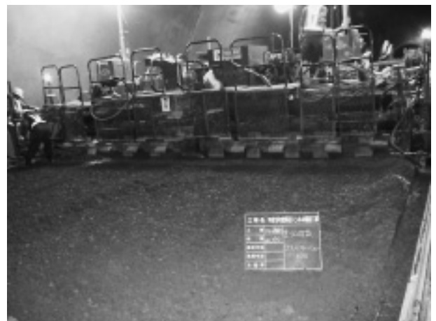
写真-5 二車線同時施工状況
