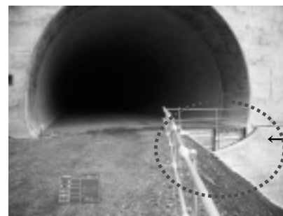
写真-1 着手前終点部
