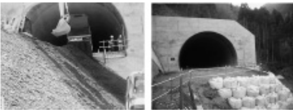
写真-3 終点部の盛土状況 (右:完了)
