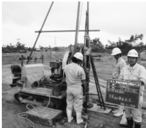
写真-3 隣接工区盛土部での調査ボーリング
