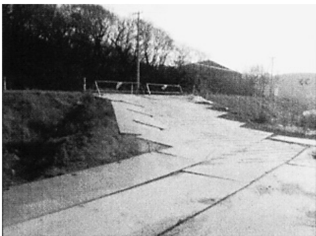
写真-1 搬出入路
