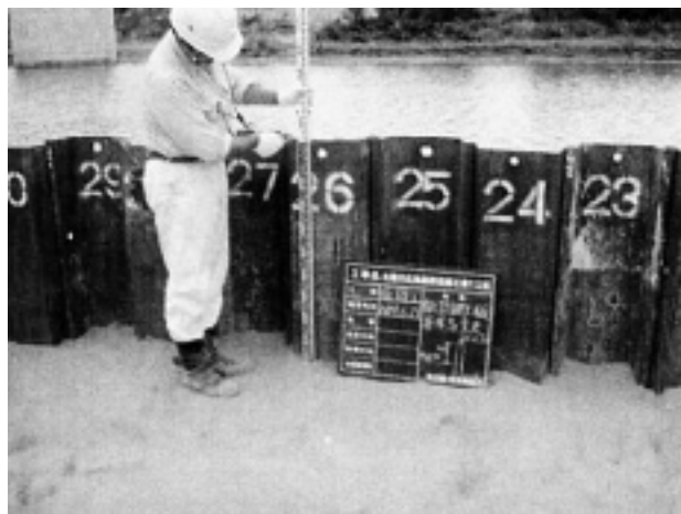
写真-2 仮設締切矢板
