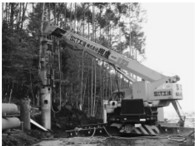
写真-2 杭打ち機削孔作業
