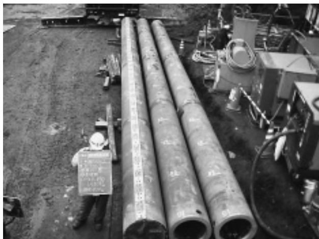
写真-1 鋼管杭 L=15.0m (溶接製品)
