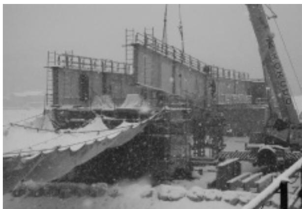
写真-1 桁架設状況
