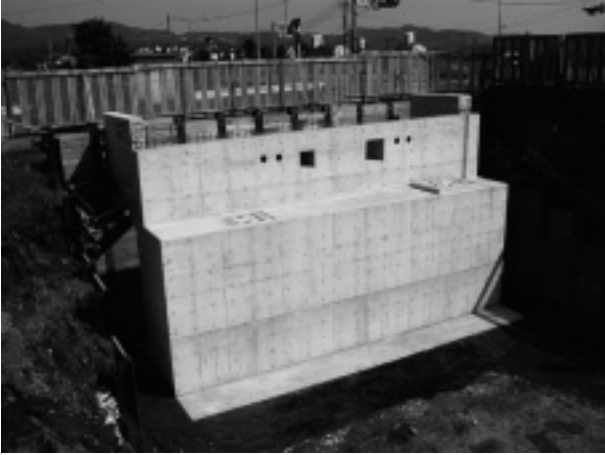
写真-4 躯体完了全景
