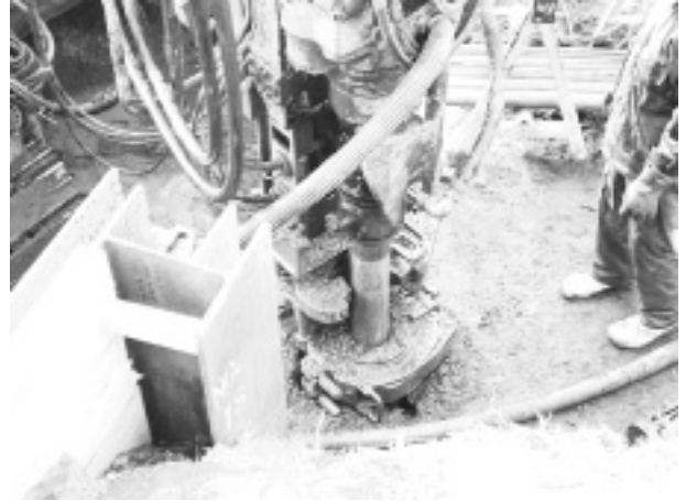
写真-1 親杭削孔状況
