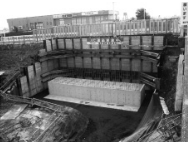
写真-2 躯体1ロット完了時の土留状況
