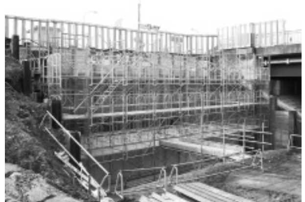
写真-3 足場設置完了時
