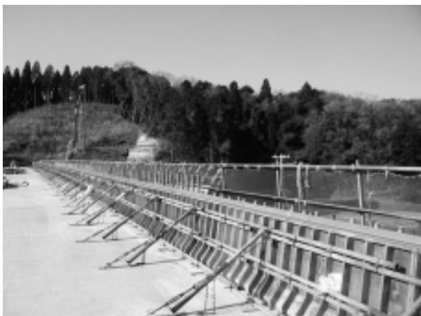
写真-3 型枠組立完了
