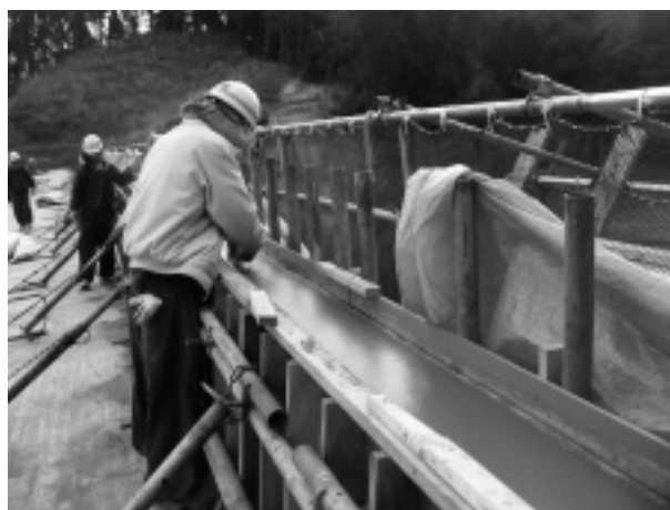
写真-5 仕上げ状況
