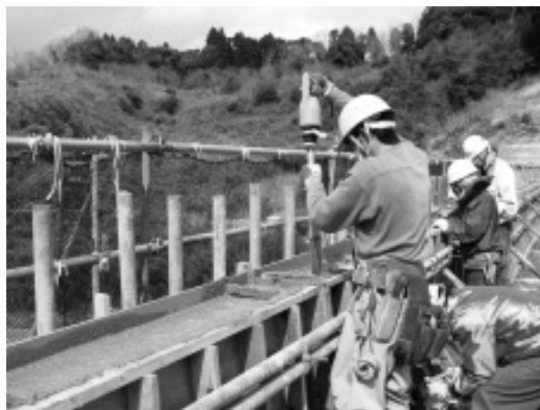
写真-4 コンクリート打設状況
