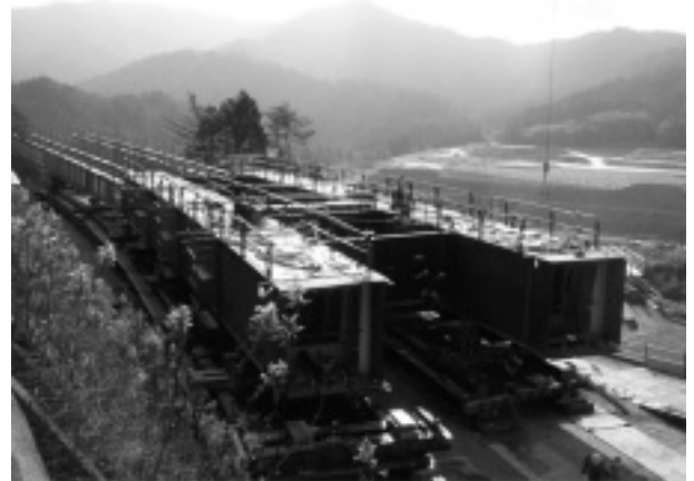
写真-1 桁組立状況
