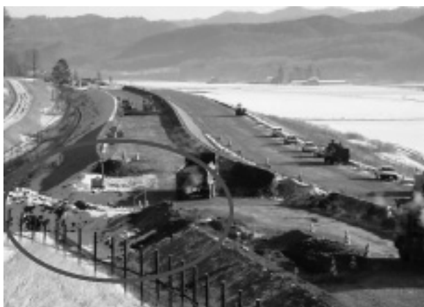
写真-2 起点側の仮設進入路
