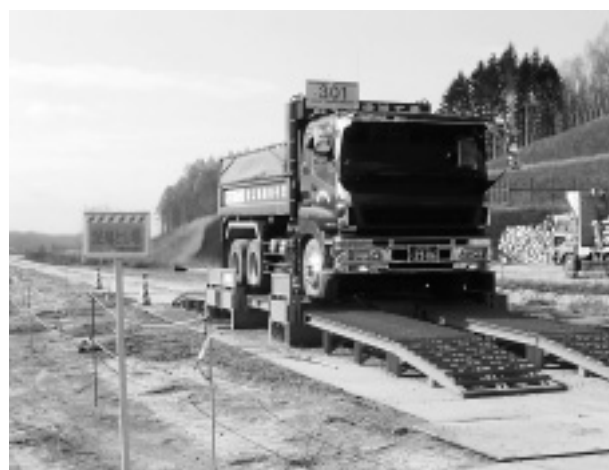
写真-3 泥落としスパッツ設置
