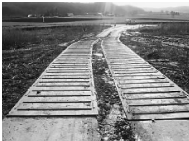
写真-1 斜路の凹凸敷き鉄板
