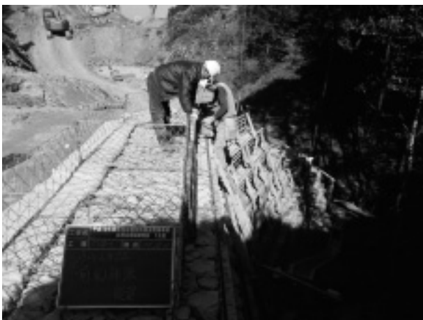
写真-2 前面補強（下部）
