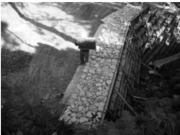
写真-3 前面補強（上部）
