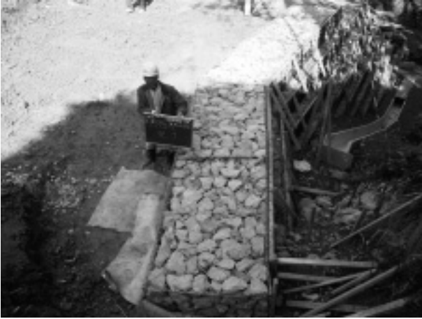
写真-5 中間折れ点部完了
