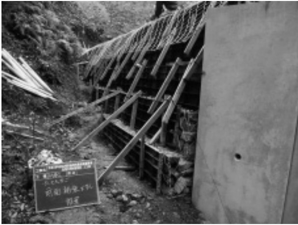
写真-1 前面補強（下部）
