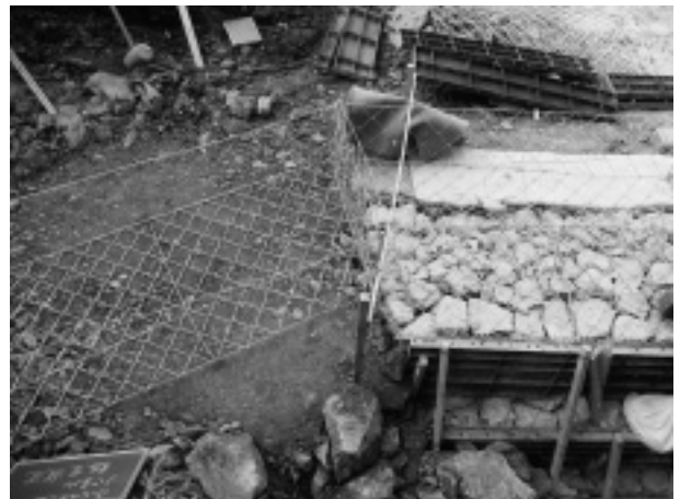
写真-4 中間折れ点部パネル組立
