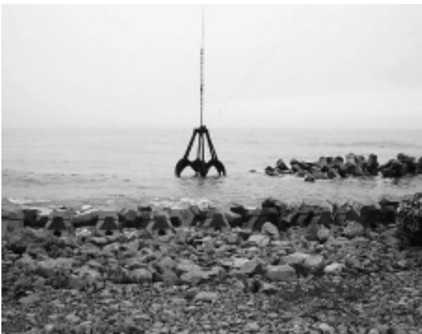
写真-2 オレンジピールバケツでの回収状況
