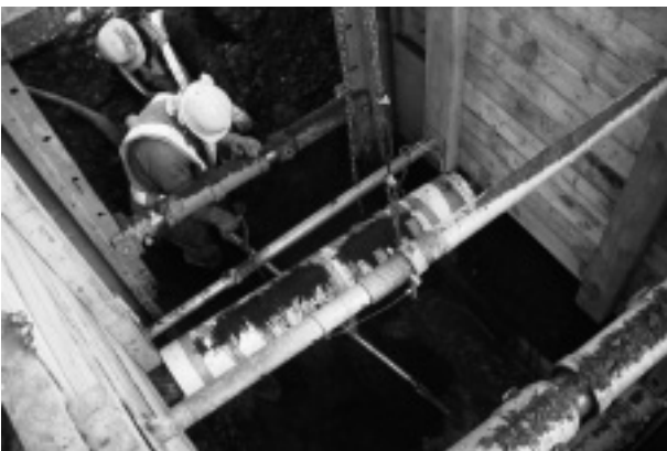
写真-2 水締め填圧
