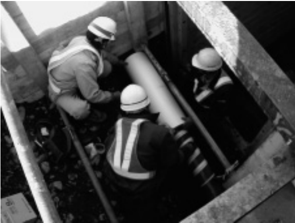
写真-1 水道管凍結防止対策
