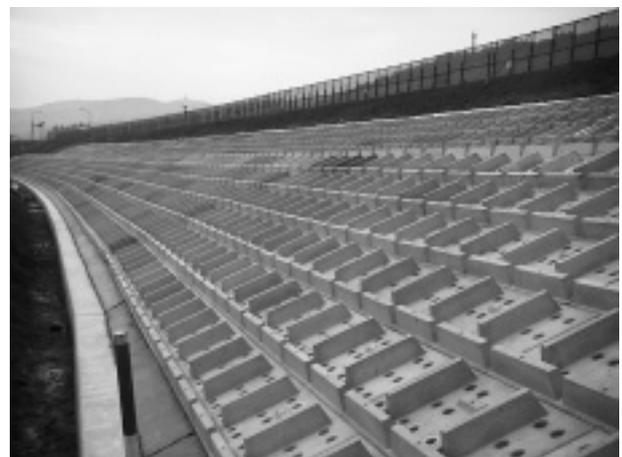
写真-1 大型連節ブロック完了
