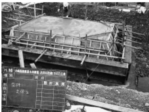
写真-1 型枠組立完了
