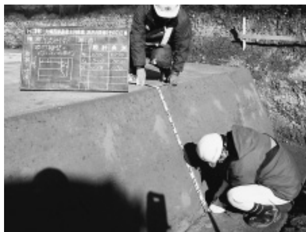
写真-2 均しコンクリート完了
