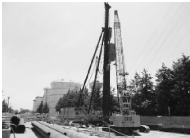
写真-3 中掘り機と相番クレーン平行作業
