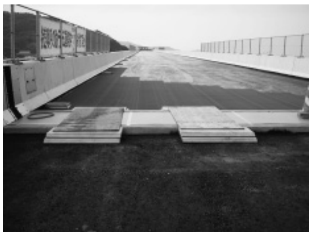
写真-6 専用ステップ設置
