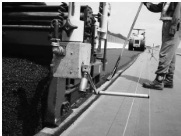
写真-3 センサーロープ設置
