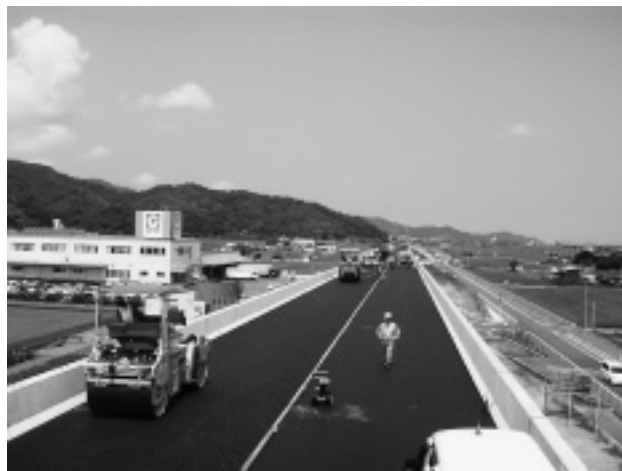
写真-4 表層施工状況
