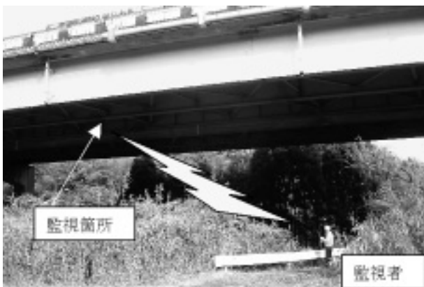
写真-4 受信機による監視状況
