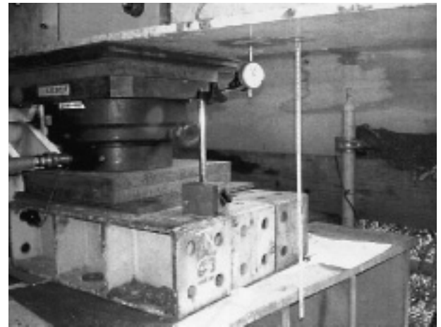
写真-5 ジャッキと高さ計測メジャーによる監視状況
