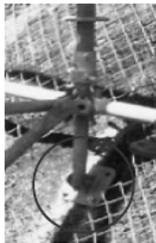
写真-3 ジャッキ固定状況 (角度自在型)
