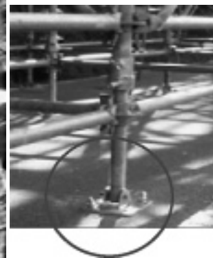
写真-4 ジャッキ固定状況 (角度固定型)
