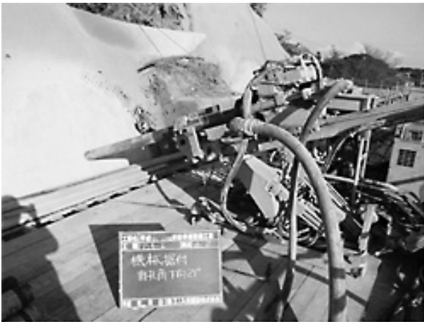
写真-7 グラウンドアンカー削孔状況
