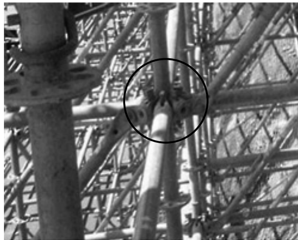
写真-2 部材連結状況
