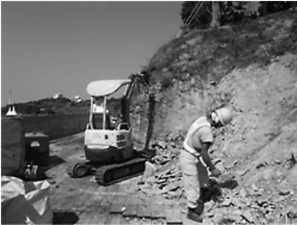
写真-6 既設吹付モルタル取壊状況
