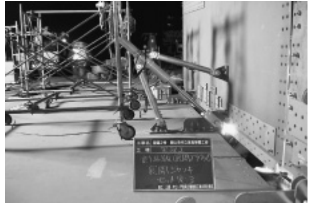
写真-3 ジャッキによるブラケット展開
