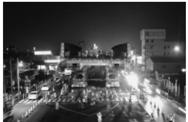
写真-1 P3-P4架設
