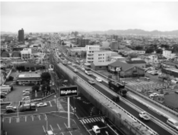
写真-2 暫定2車線供用
