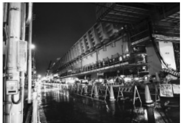
写真-3 鋼桁一括吊上げ状況（夜間）
