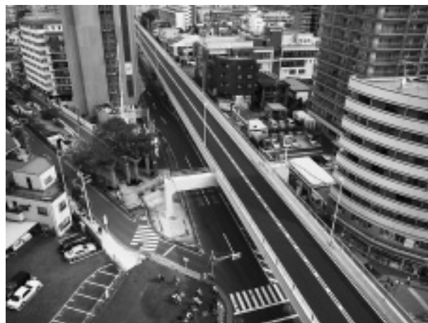
写真-6 新小岩陸橋完成
