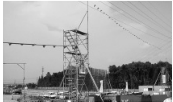
写真-3 赤色三角巾付ロープ設置状況
