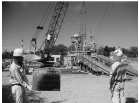
写真-4 監視員配置状況
