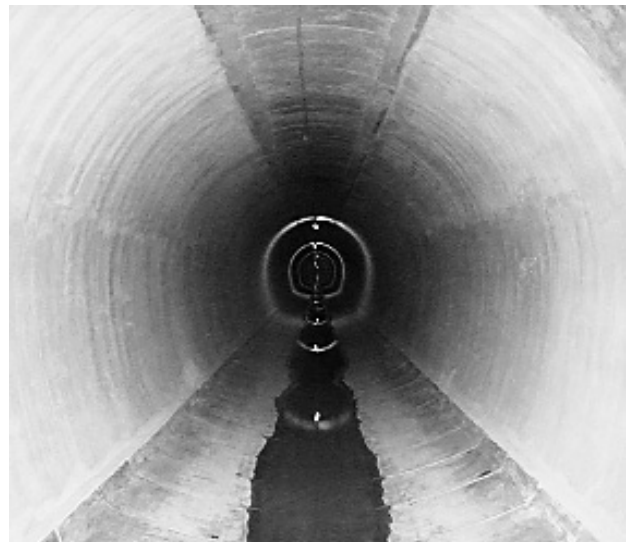
写真-1 標準部完成状況
