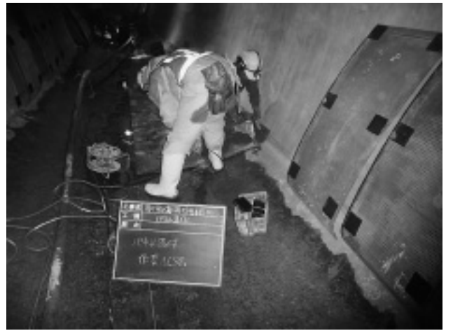
写真-7 ダグタルパネル設置状況
