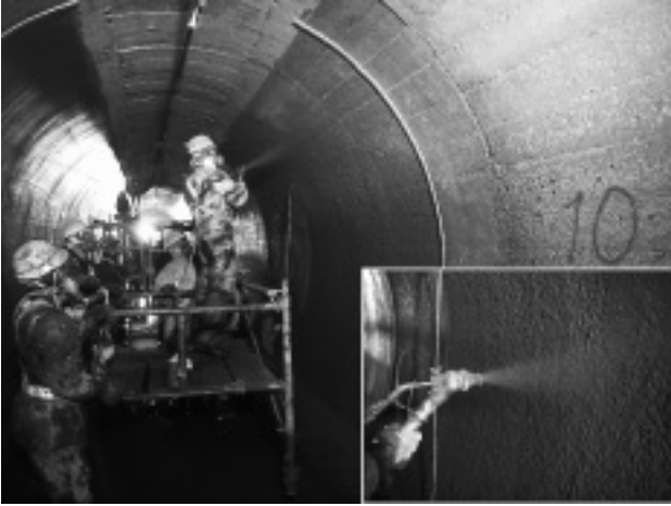
写真-4 PCM吹付け状況
