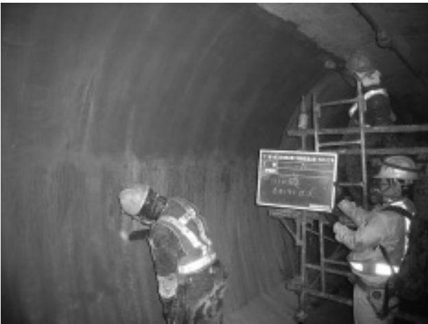
写真-5 PCMコテ塗り状況
