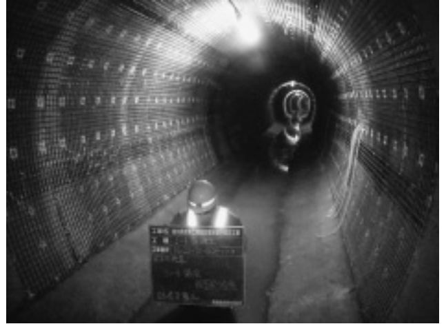
写真-6 カーボングリッド設置状況
