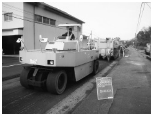
写真-2 切削機による打ち換え状況
