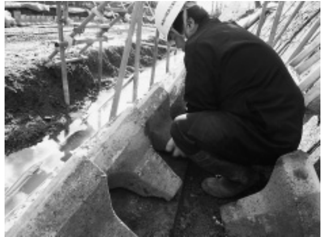
写真-1 ブロック（根石）据付状況
