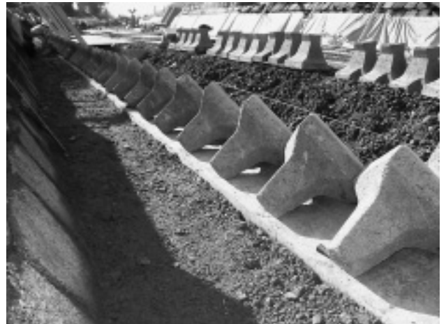
写真-2 ブロック（根石）据付完了
