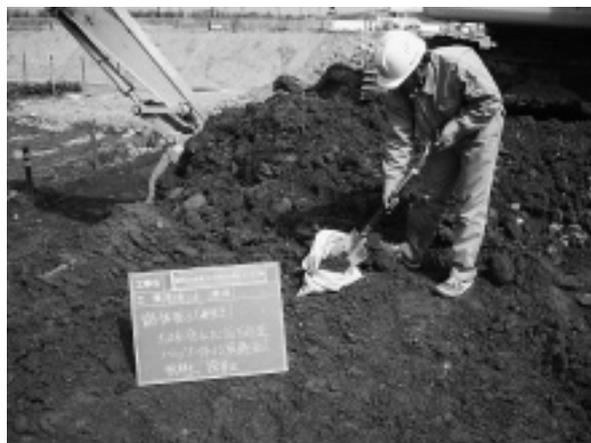
写真-4 掘削土自然乾燥試料採取
