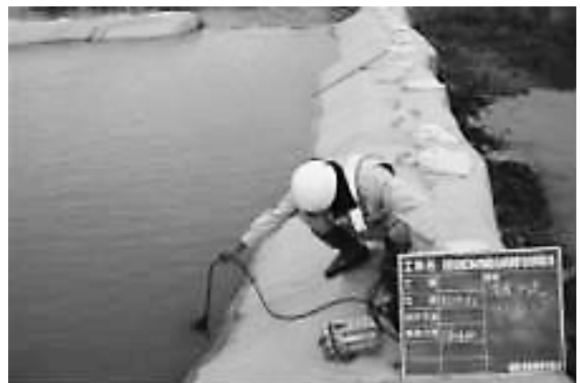
写真-7 濁度測定状況
