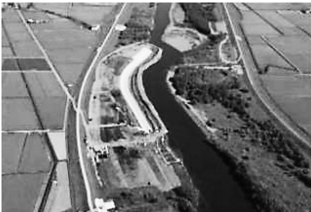
写真-2 右岸仮締切り施工状況
