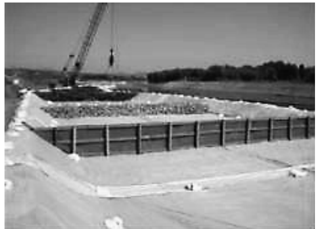
写真-6 ろ過池全景
