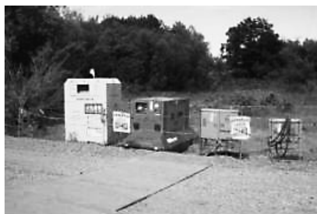
写真-9 油流出防止型ホームタンク設置状況
