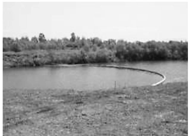
写真-4 シルトフェンス設置状況
