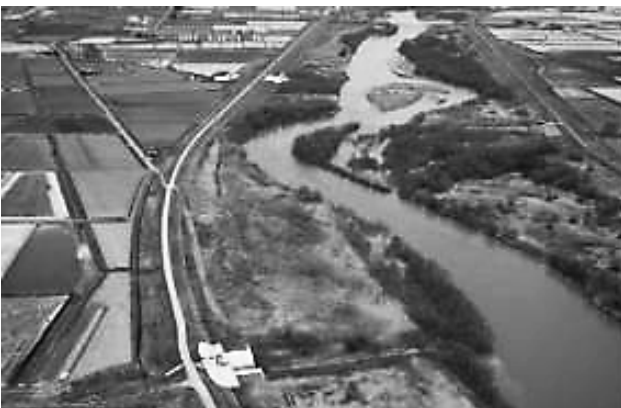
写真-1 工事箇所全景
