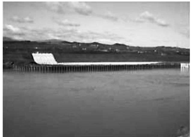
写真-3 袖部鋼矢板打設完了全景
