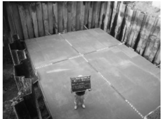
写真-7 仮締切完了
