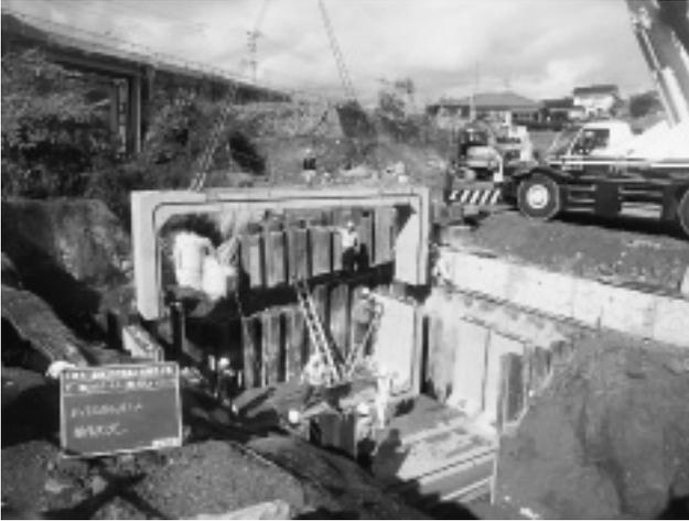
写真-8 ボックス据付状況
