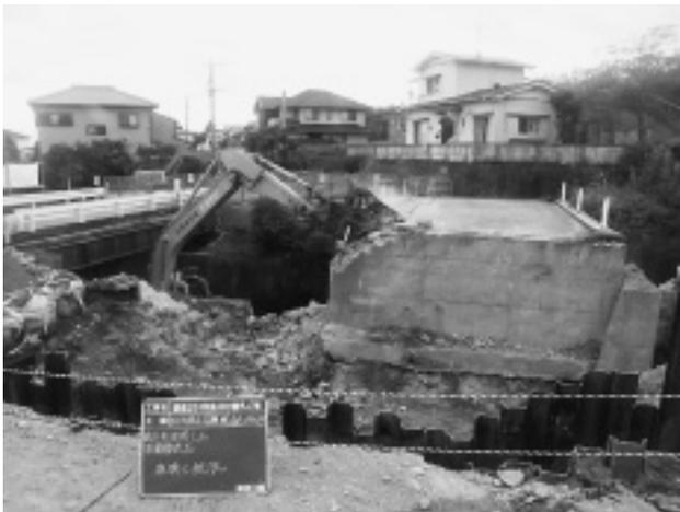
写真-6 大型ブレーカから油圧クラッシャーへ変更
