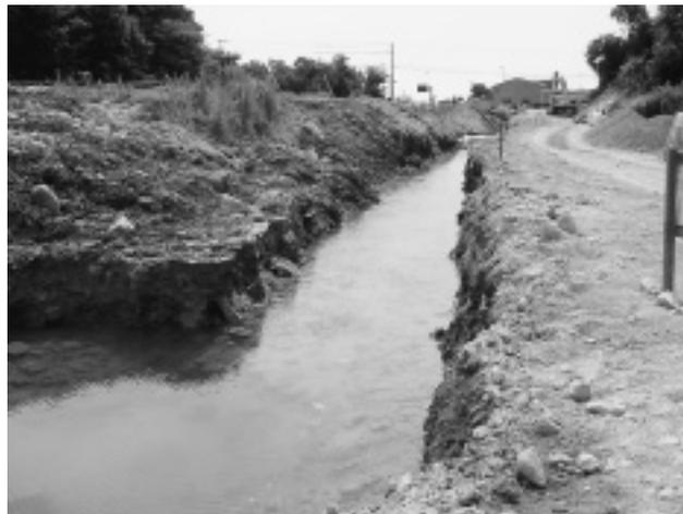
写真-1 掘削時湧水
