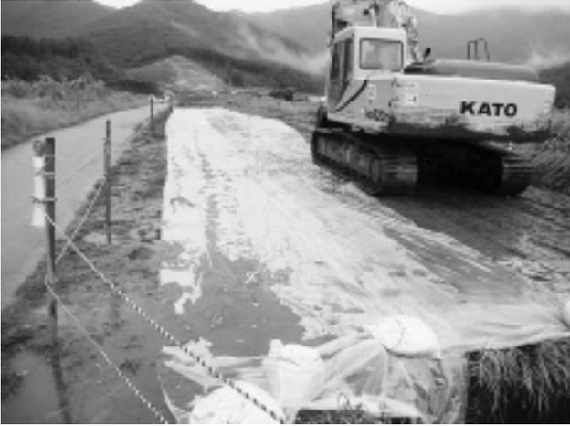
写真-5 降雨流下箇所ビニールシート敷設
