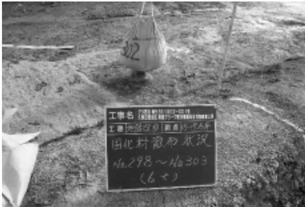
写真-9 固化材散布状況
