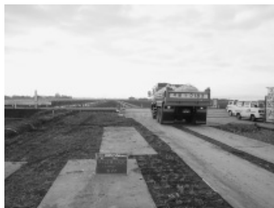
写真-8 固化材搬入状況
