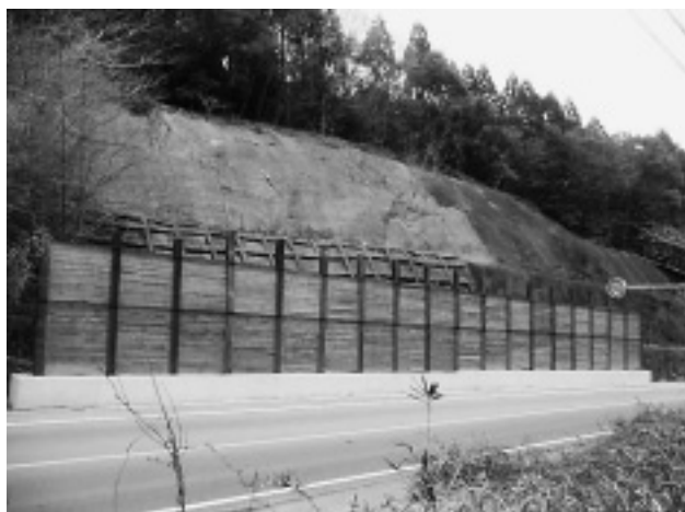
写真-1 現場状況
