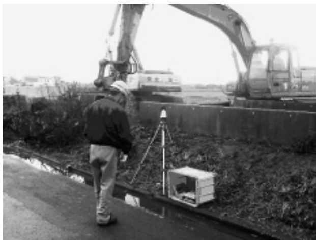
写真-4 騒音・振動調査（構造物撤去作業中）
