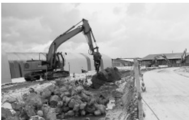
写真-3 既設用水路圧碎状況
