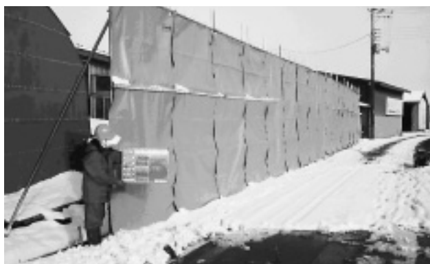
写真-6 牛舎前防音シート設置
