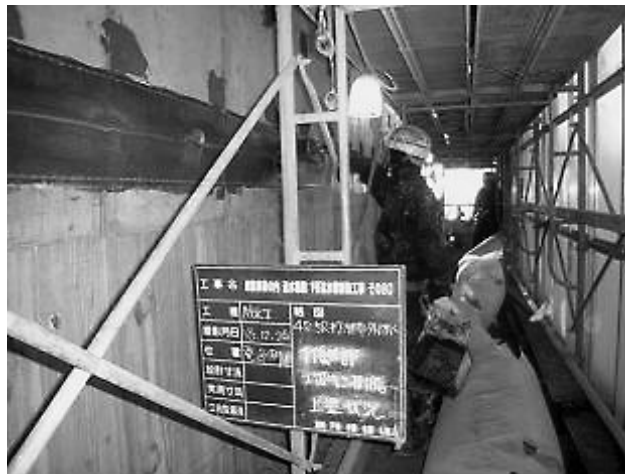
写真-4 外面防水施工状況
