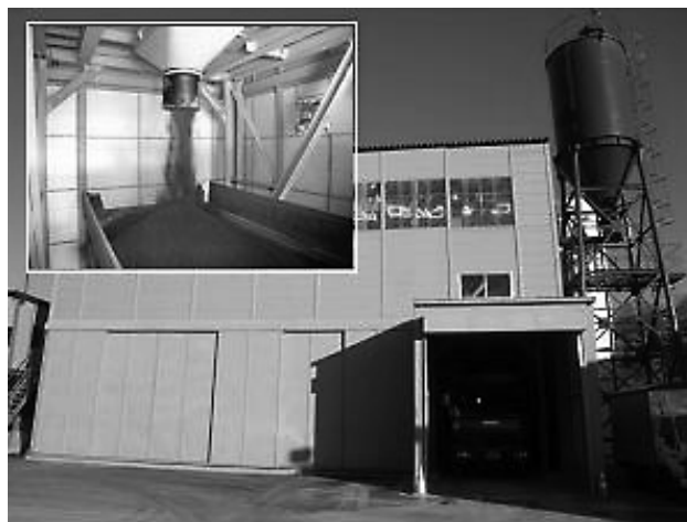
写真-1 ソイルセメント練り混ぜ状況
