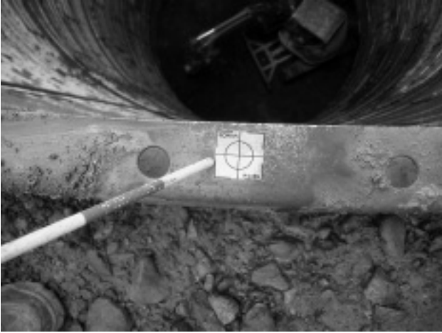
写真-2 反射シート設置
