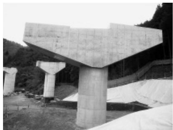
写真-5 完成 (BP4 橋脚)
