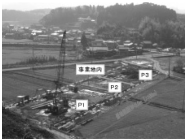
写真-1 現場全景
