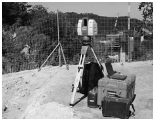
写真-2 3Dレーザースキャニング測定
