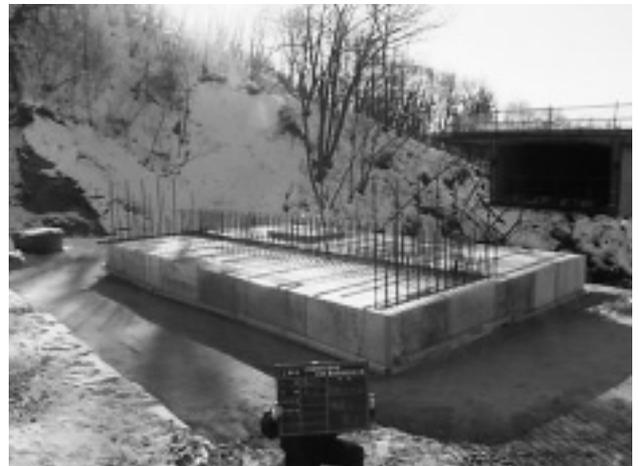
写真-3 断熱材養生実施状況
