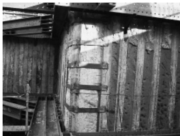
写真-2 出隅補強
