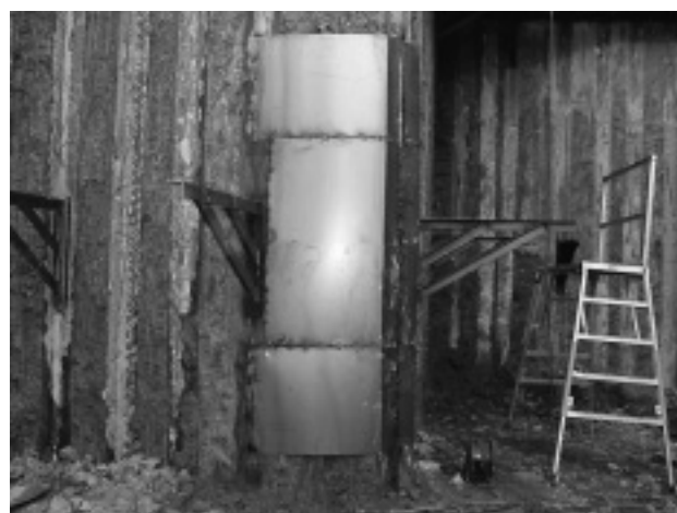
写真-3 漏水による出隅補強
