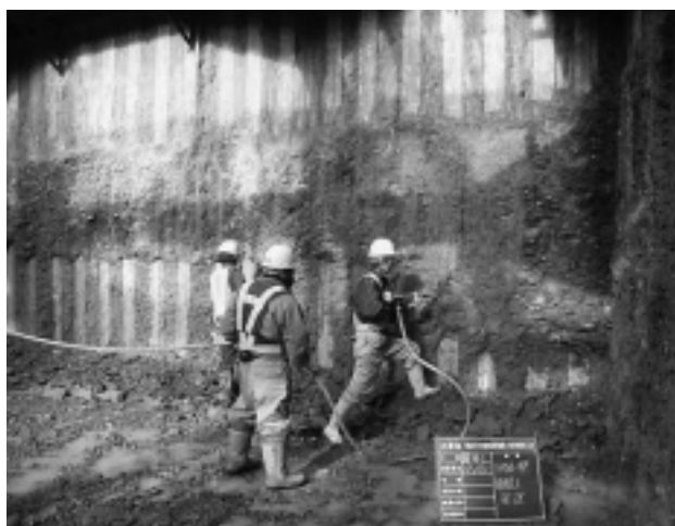
写真-1 ソイルセメント解体状況
