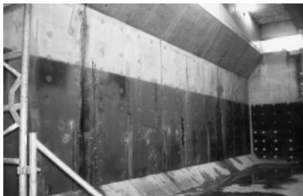
写真-3 【反応タンクひび割れ発生位置 (D・5 壁)】
