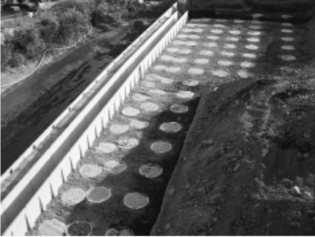
写真-4 深層改良完了
