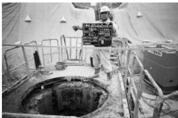
写真-3 鉄筋かご高測定状況
