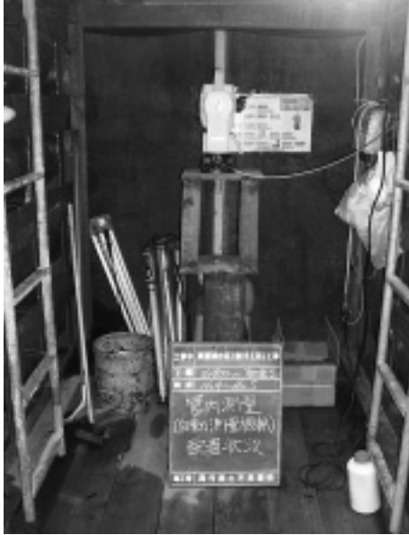
写真-3 自動測量機器 (立坑内)
