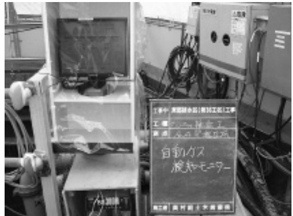
写真-7 定置式ガス測定器
