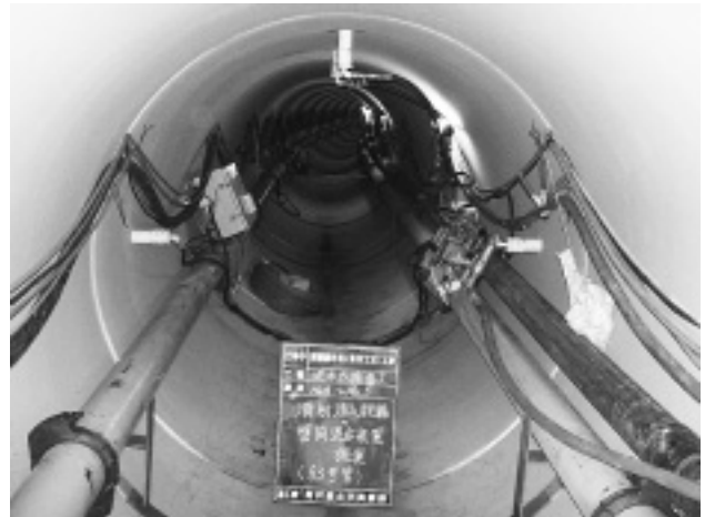
写真-1 滑材注入装置
