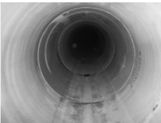
写真-10 施工完了
