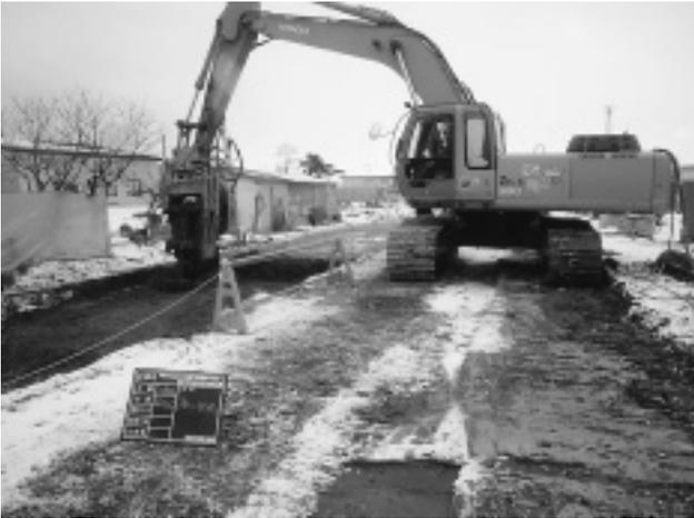
写真-3 地盤改良攪拌作業
